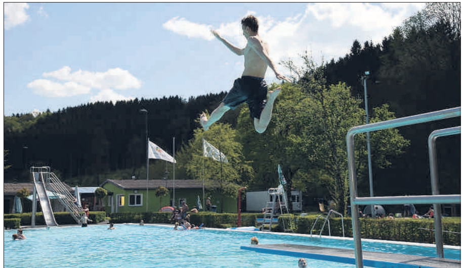
Freudensprünge machen nur noch die Besucher: Seinen Betreibern bietet das Bielsteiner Freibad wenig Anlass zur Freude: Die Technik pfeift aus dem letzten Loch, zum Teil gibt es schon keine Ersatzteile mehr. (Archivfoto: Dierke)
